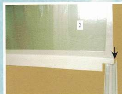
Вставить подвижную створку № «2» бегунками в пазы направляющих профилей
