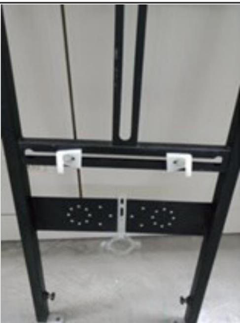
Заранее разметьте крепления на инсталляции для крепления писсуара.
